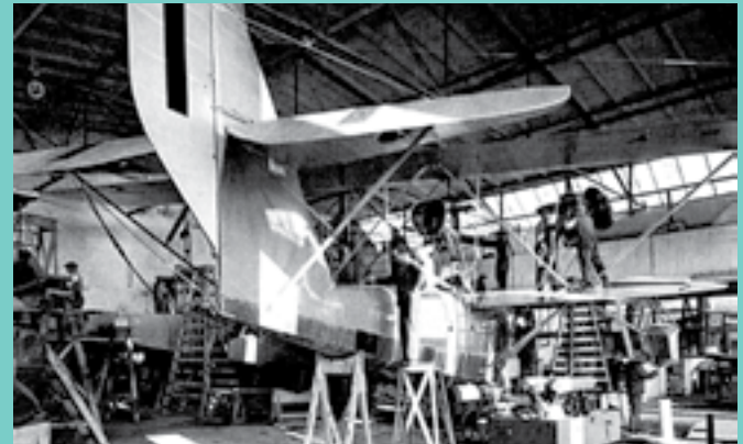
Officine aeronautiche: montaggio di un Cant 22 RI
